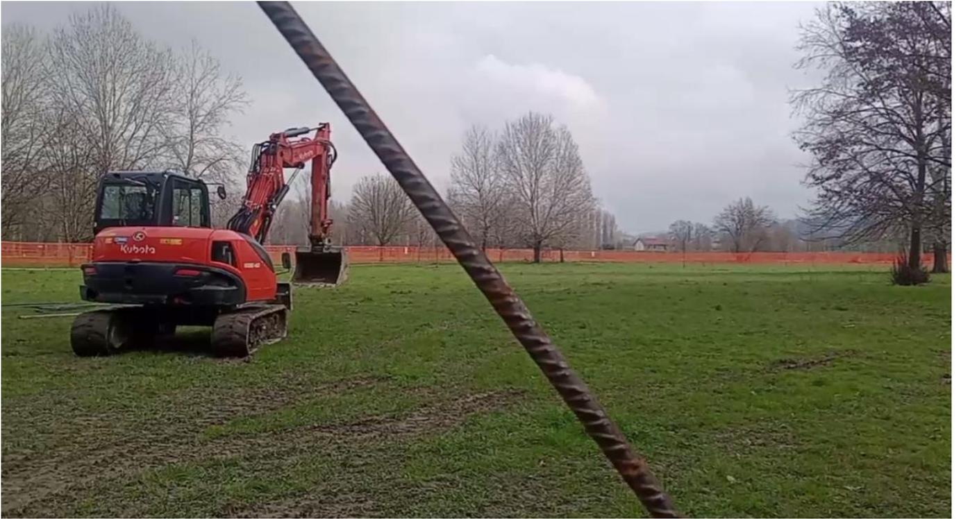
Scavi e compattamenti, copertura del terreno con geotessuto in materiale sintetico (cfr. Tavola 25a-104\_1\_ESE\_5056\_ARC\_ELAB.GRAF.25a-01).
