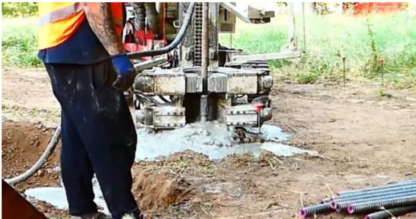
Posa di micropali per la passerella con iniezione (e sversamento) di cemento (lato tettoia, 20/06/2025)
