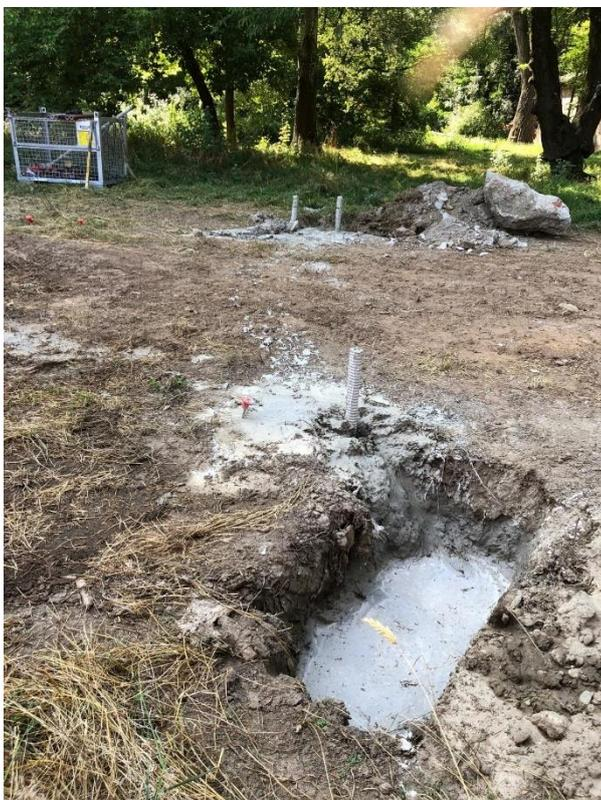
**17/06/2025** Iniziano le trivellazioni e le iniezioni di calcestruzzo per i micropali di sostegno della passerella ciclopedonale (lato Borgata Rosa). Si sversa il cemento in eccesso nel terreno (foto del 18/06/2025).
